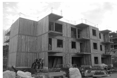
CLTパネル工法を導入することにより、工期の短縮を図るとともに、木材の利用を促進。
