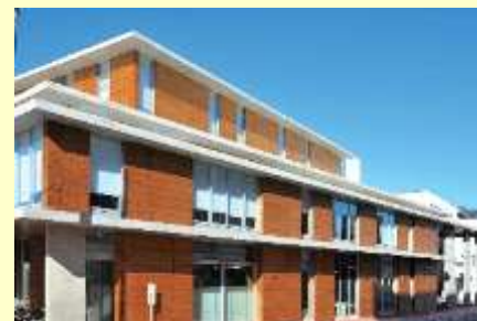
耐火構造として防火被覆を設けたことにより、化粧材に木材を張るなどの措置が必要となった例
