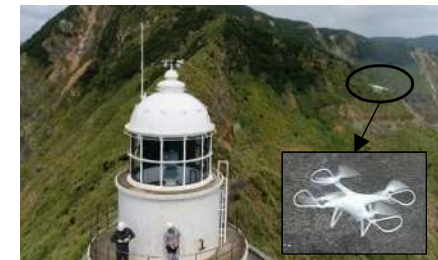
施設点検へのドローン活用
