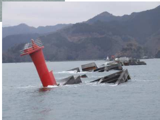
災害による被害
