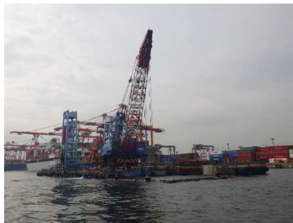
東京区における海上工事
