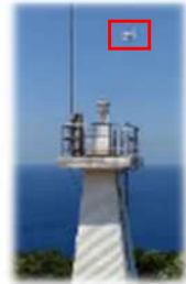
ドローンによる施設点検
