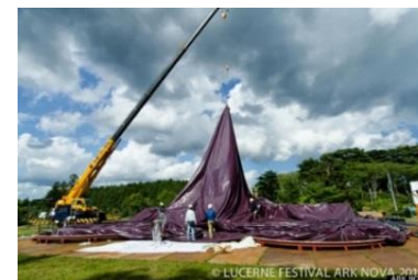
設置中の様子
