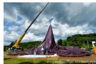
設置中の様子
