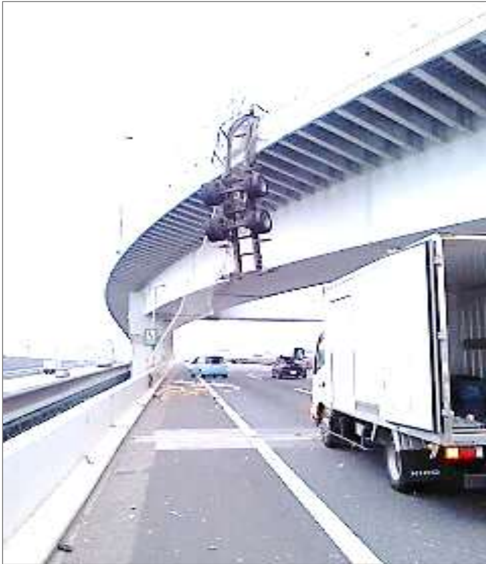
写真5-3 宙づりになったコンテナセミトレーラ (首都高速湾岸線西行きから)
