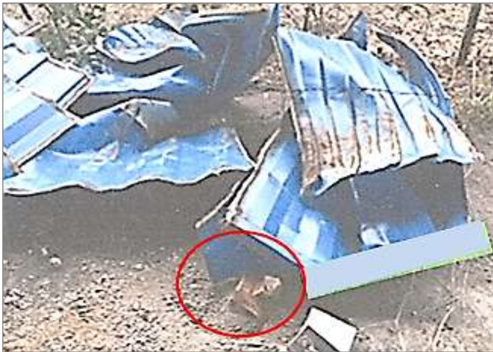
写真4 破損した緊締装置の一部（○印）
