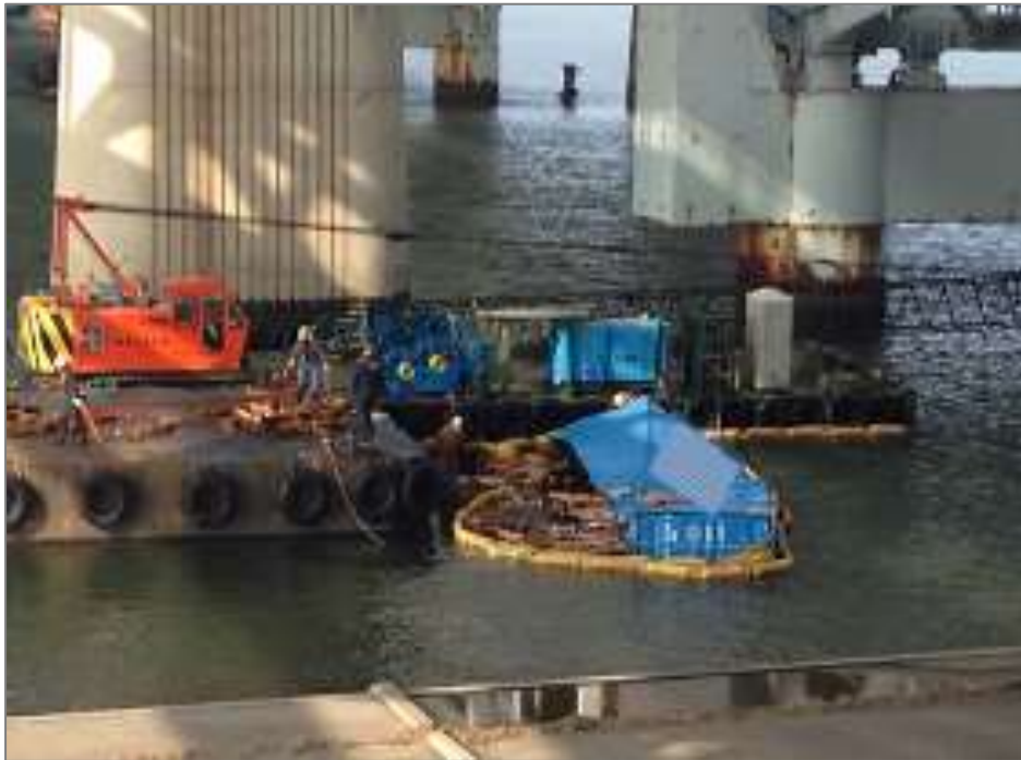
写真7 国際海上コンテナ回収状況
