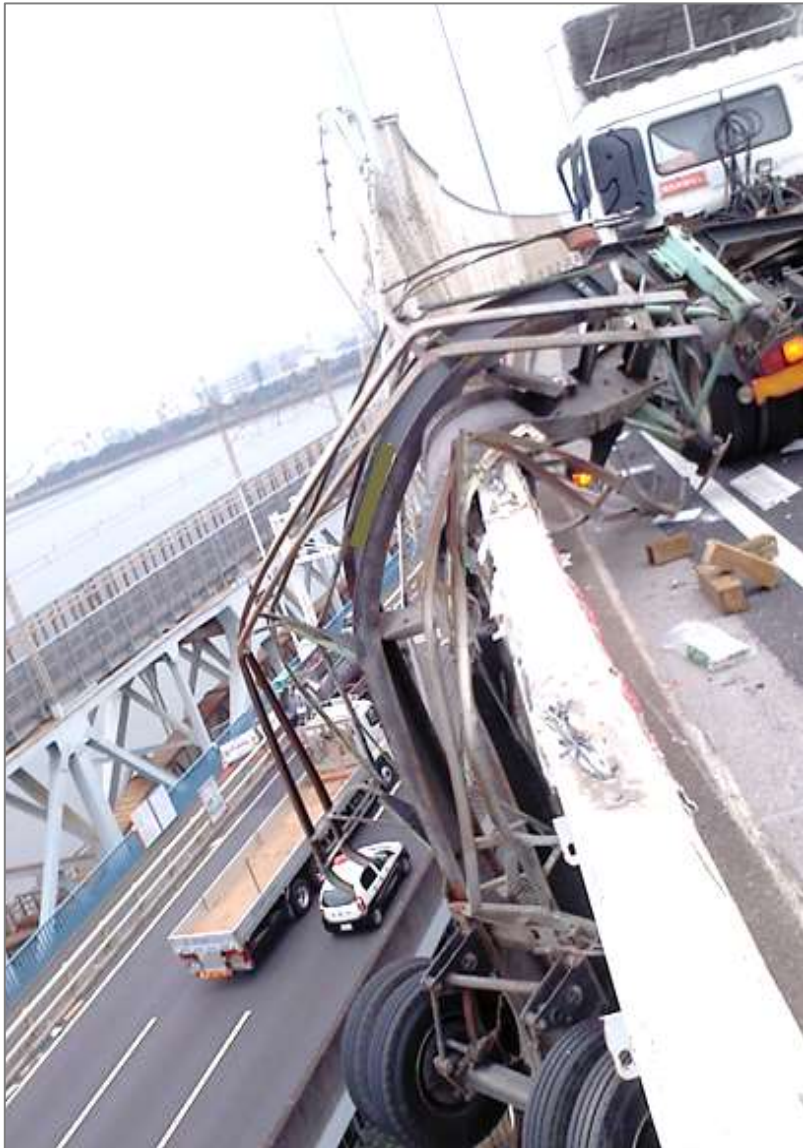
写真5-2 宙づりになったコンテナセミトレーラ
