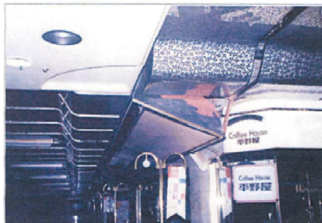
阪神淡路大震災時で被害を受けた三宮地下街の天井崩落
