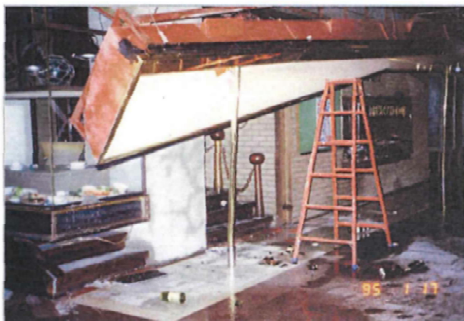
阪神淡路大震災時で被害を受けた三宮地下街の天井崩落
