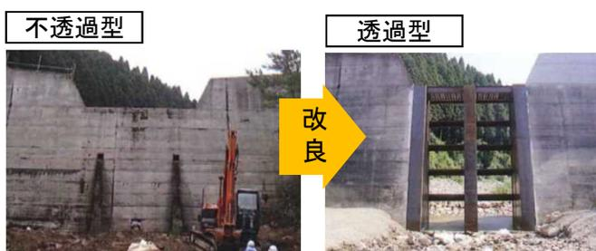
⇒ **土砂・流木捕捉効果の高い透過構造の砂防施設により土砂・流木の流出を防止**
