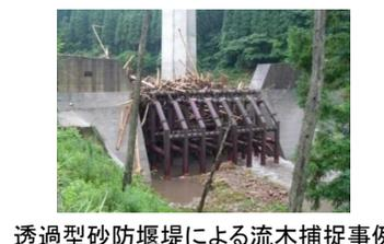
透過型砂防堰堤による流木捕捉事例
