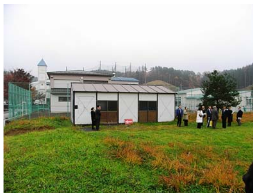
松園地区の空き家の状況
