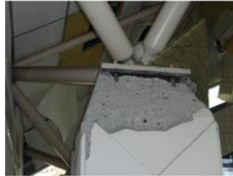
(b) RCS接合部の被害
