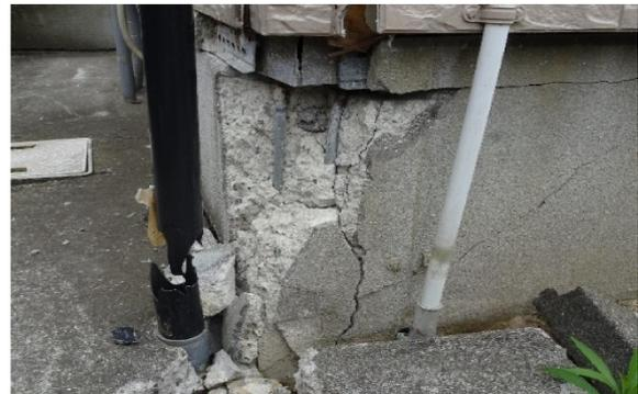
図2 地震時の出隅部の被害
