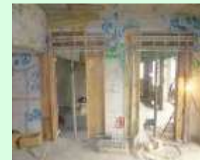
内壁等の補強
