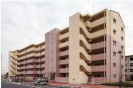
例:鉄筋コンクリート造
