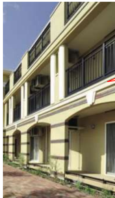
木材が見えなくなる防火被覆が設けられている
