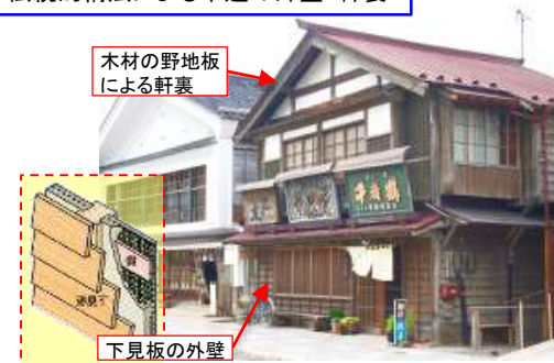
伝統的構法による木造の外壁・軒裏
