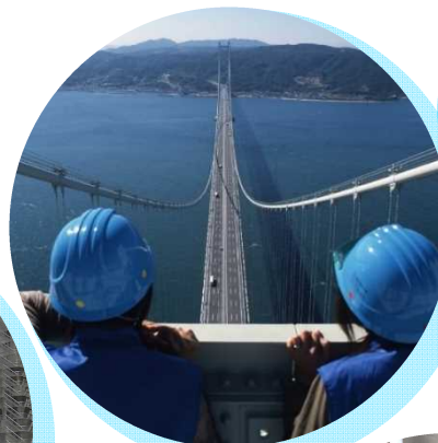
明石海峡 大橋
