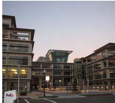
図 CalPERS本部ビル(LEED Gold)
