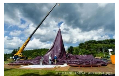
設置中の様子
