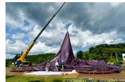
設置中の様子
