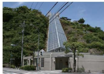
法人で所有・管理する斜行エレベーター [グリーンヒルズ湯の山(愛媛県松山市)]
