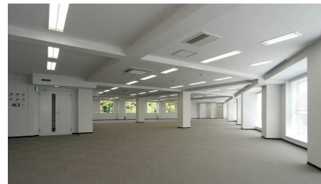
改修後の室内。南東側(写真右)の窓を拡大し眺望・美観を確保した。
