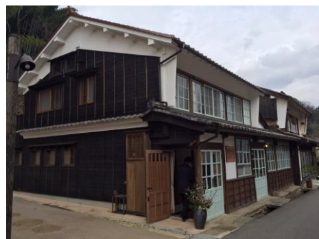
旧大森郵便局舎の改修によるオペラハウス 「大森座」
