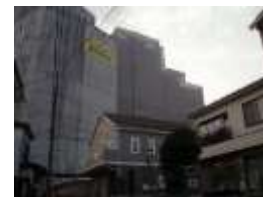
戸建て住宅地の高層マンション
