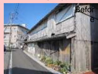
空き家の除却
