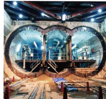
地下鉄の建設 (3 連シールド工法)
