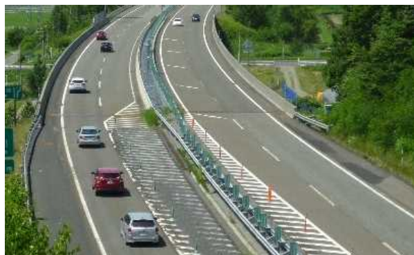
【付加車線の設置事例(写真-1)】
