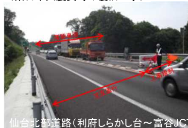
<東日本大震災時の復旧工事>
