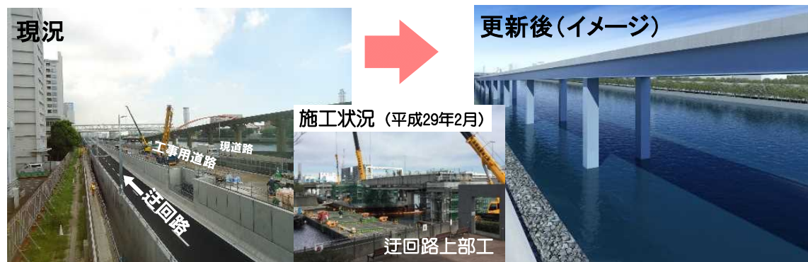
写真-2 更新の事例: 首都高速 東品川栈橋・鮫洲埋立部
