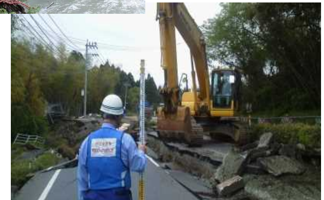
■ 重機による盛土復旧作業を実施
