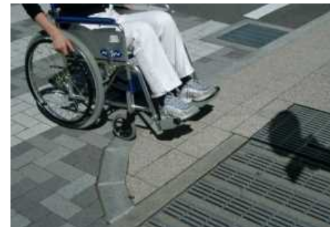
歩車道の段差解消
