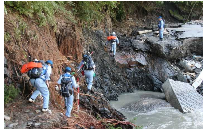
■ 被災状況を現地で調査
