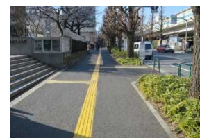
視覚障害者誘導用ブロック
