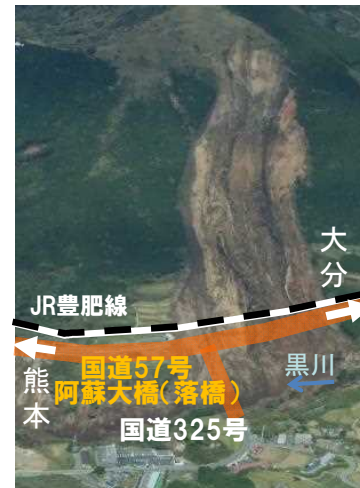
斜面崩落と阿蘇大橋の落橋 (国道57号・国道325号)
