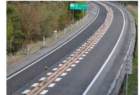
<ワイヤロープの設置事例>
