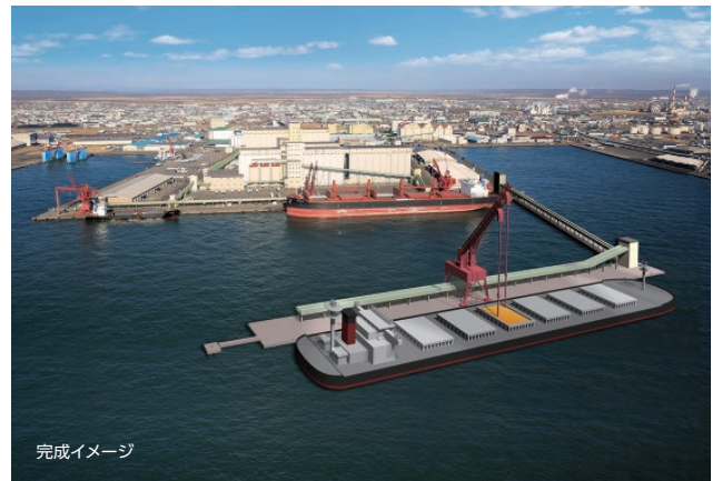
平成29年度完成予定の西港区第2埠頭の係留施設 (水深14m、延長300m)
