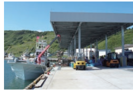
屋根付き岸壁
