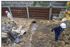
工事に伴う埋設物の損傷事故
