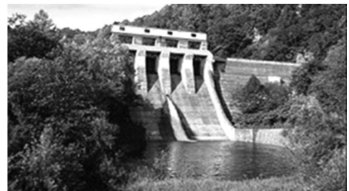
かさ上げ予定の雨竜第2ダム
