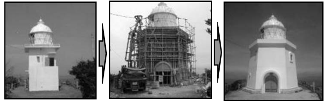
▲補強前 ▲耐震補強 ▲補強後
