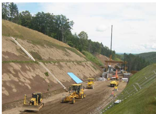
施工現場全景
