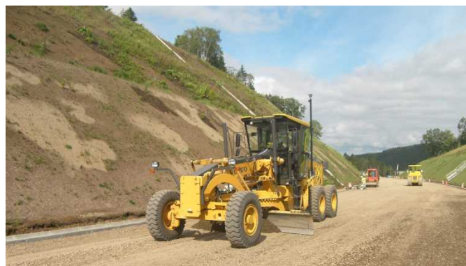
MCグレーダ作業状況
