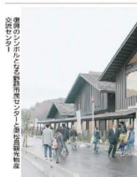
東松島市野蒜地区の交流施設。交流施設は、震災で被災した東松島市・野蒜地区に、約1,000戸の住宅を建て、278区画の宅地引き渡しを完了した。また、交流施設も開所した。
