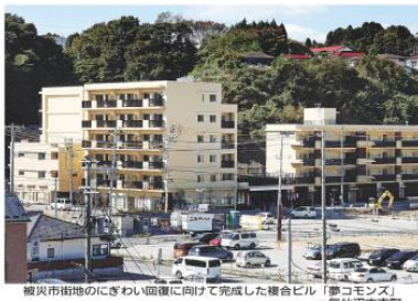
被災市街地のにぎわい回復に向けて完成した複合ビル「夢 commons」＝気仙沼市南町
