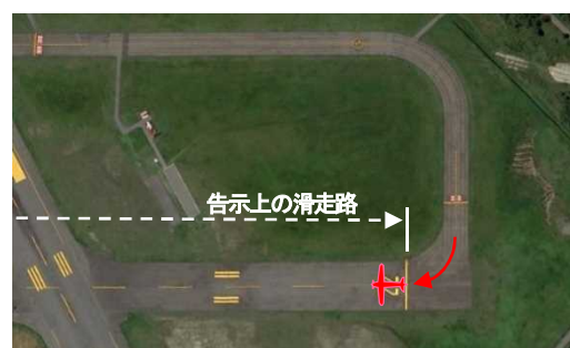
図-4 取付誘導路（新潟空港A滑走路）
