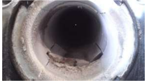
試験炉の内部
