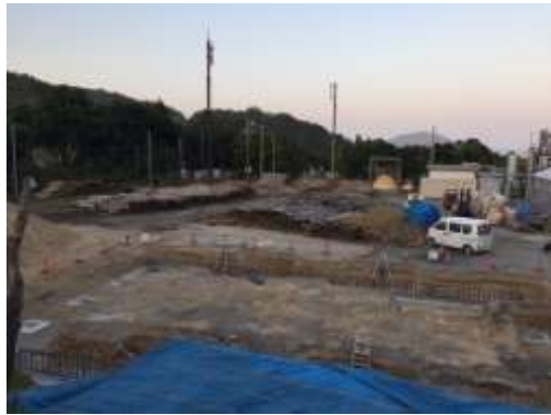
サンコールの竹炭加工施設を建設中
