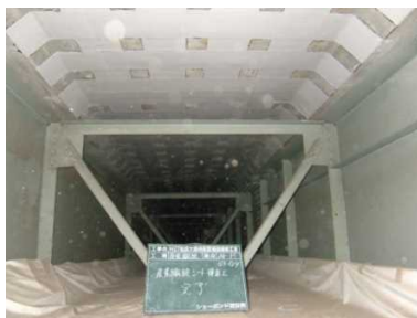
炭素繊維シートの貼り付け
