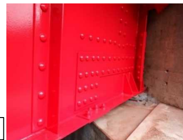
桁端部の当て板・塗装
