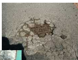
(床版上面) 舗装土砂化
