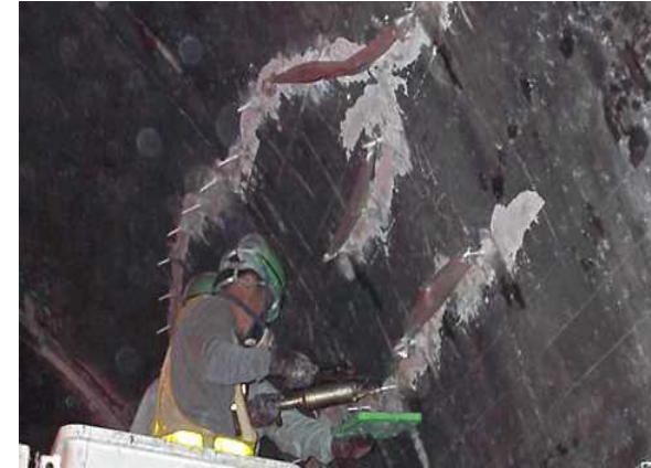
トンネル補修
