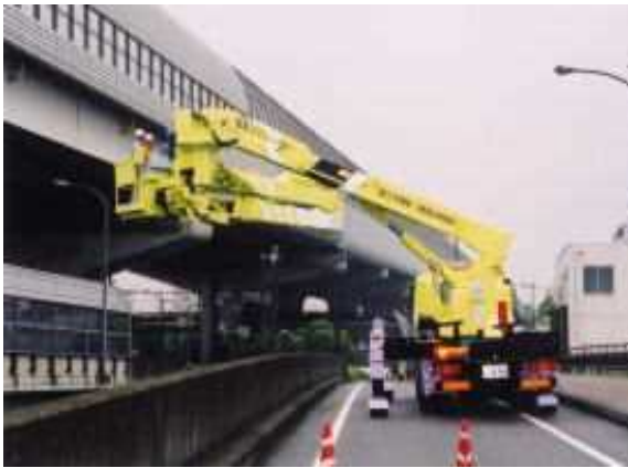
橋梁等構造物の点検
