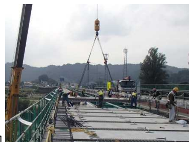
プレキャスト床版による 打ち替え
