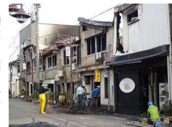
火元建物付近の様子
