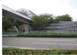
・長い急勾配スロープ(勾配1/10)
