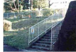
・敷地内随所にある階段
