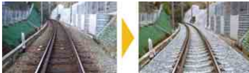
神戸電鉄鈴蘭台駅～鈴蘭台西口の曲線部における速度制限機能付きATS等の整備前（左）と後（右）
