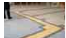
黄色と濃いグレーを組み合わせた視覚障害者誘導用ブロック
