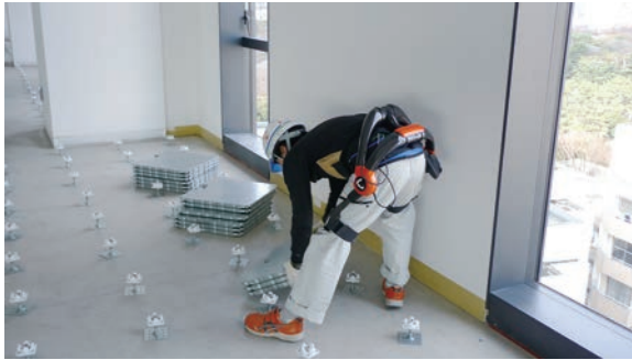
図表1-3-6 装着型ロボットの現場実証事例
