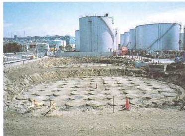
写真-4 タンク基礎
