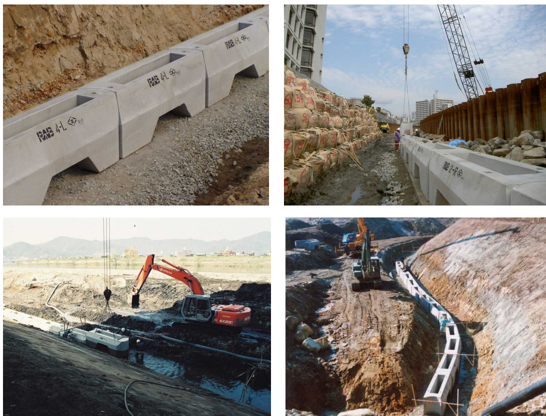
写真－1 施工状況
