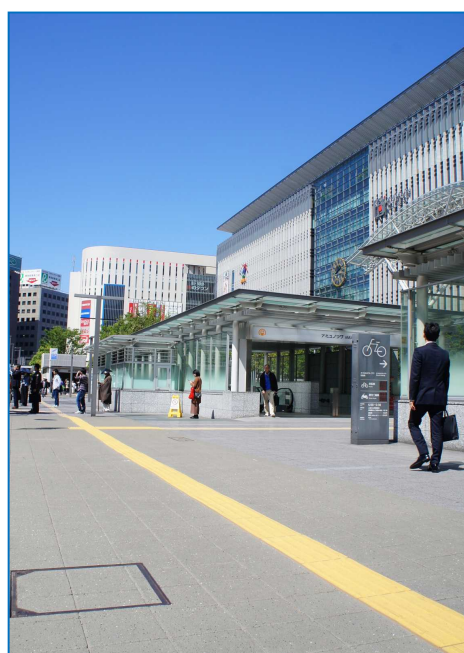
写真四 設置例
