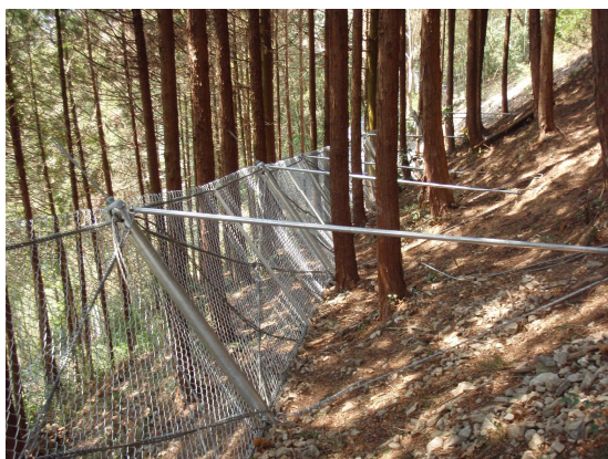
写真一 3 立木を避けた施工事例
