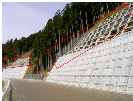
写真一 4 法枠上の施工事例
