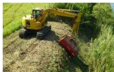
写真-5 作業状況
