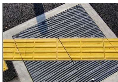
写真六 グレーチング設置
