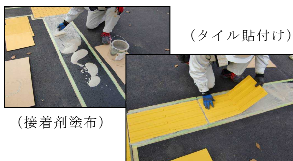
写真一 MMA点字タイル拡大（設置面：平板）
