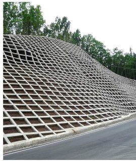
図-1 従来技術 (矩形 吹付のり枠)
