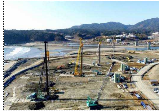
写真-2 施工状況
