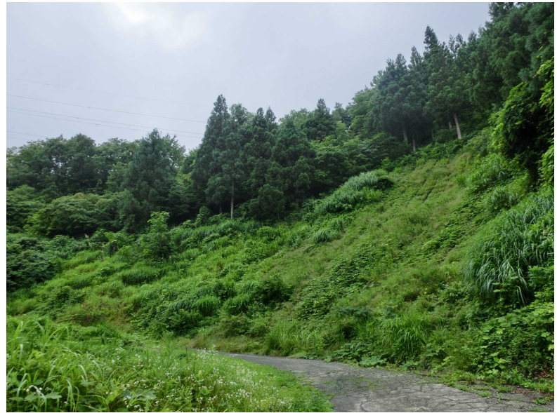
施工後 3 年 8 か月 写真-1 ソイルクリート工 追跡事例
