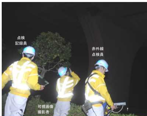
写真-1 調査状況
