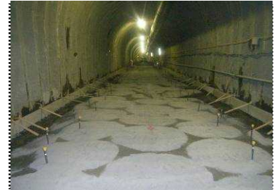
写真-5 トンネル安定対策
