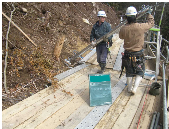
写真一 2 人力による施工
