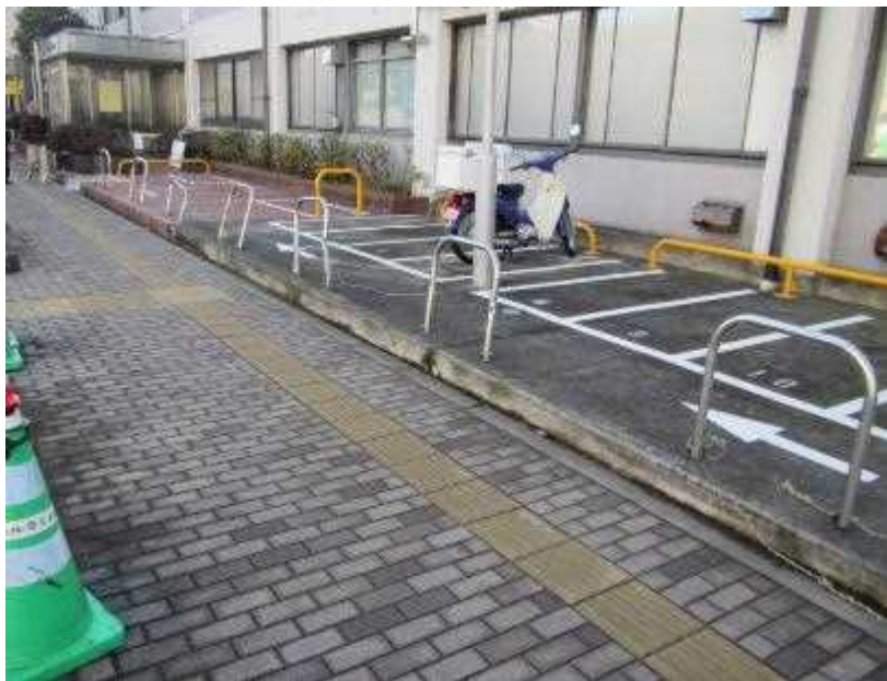
写真4 当該車両が進行した歩道及び接触したパイプ状の柵
