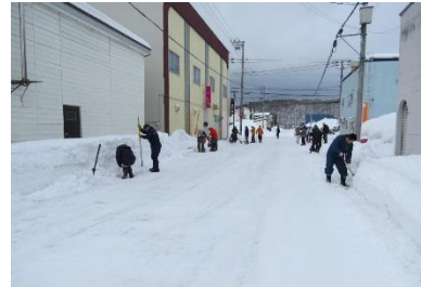
投雪溝の掘り起こし作業
