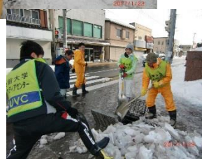
流雪溝への投入作業
