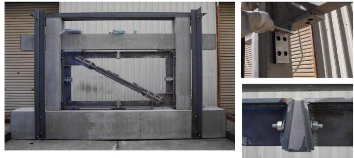
図5 RCへの適用構法(写真は昨年度施工実験)
