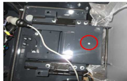
識別シール貼り付け箇所
