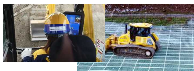
ICT建機による施工
