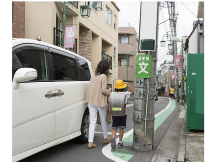
＜歩行の支障となる電柱の事例＞
