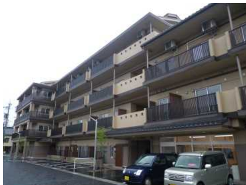
共同住宅の建設状況 (地元との連絡会議結果により 設置された福祉施設(1Fの一部))
