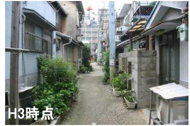
細い路地に建つ密集している老朽住宅
