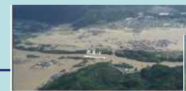
大規模な浸水被害
