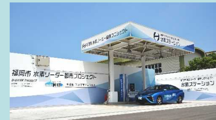
下水汚泥由来水素のステーション (福岡市中部水処理センター)
