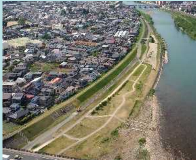
河川堤防の整備
