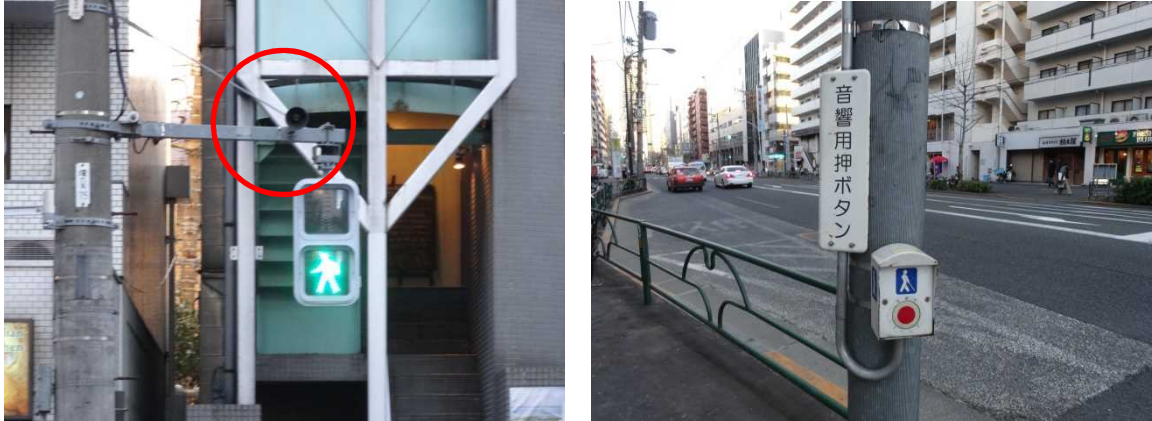
図3. 9 音響式歩行者用信号機の例（左：音響スピーカー 右：音響用押しボタン）
