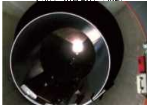
水路内に鋼管を挿入し補強
