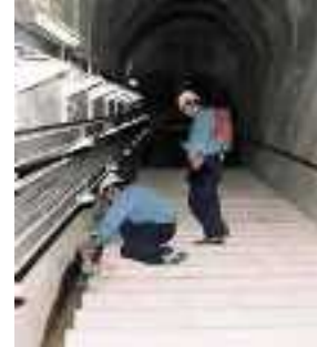
ダム堤体の観測及び施設点検
