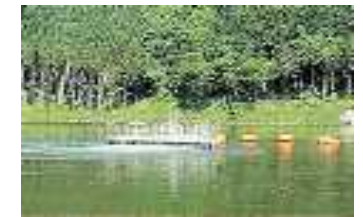
曝気循環設備(大山ダム)
