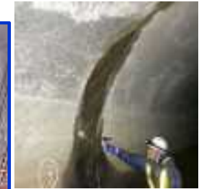
水路トンネル内の調査
