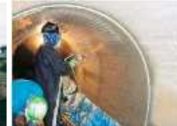
(水路トンネル内面の補強)
