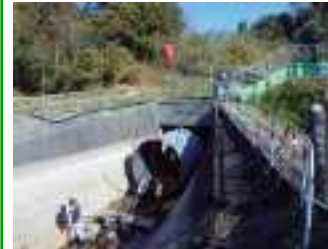
(サイホン内への鋼管の挿入)
